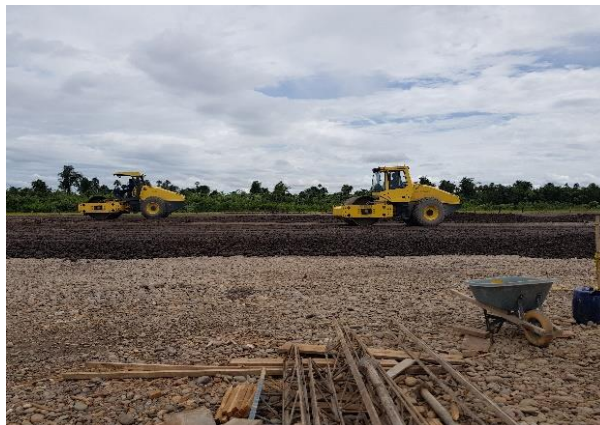
Fotografía 2-18 Cuneteo, escarificación, nivelación y compactación del terreno
