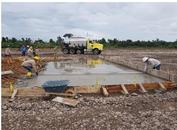
Fotografía 2-21 Construcción de placas
