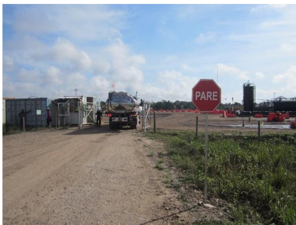
Fotografía 2-11 Cerramiento de plataforma
