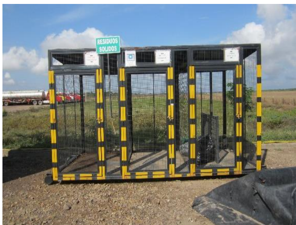
Fotografía 2-14 Caseta de residuos sólidos
