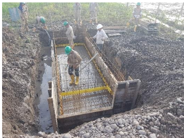
Fotografía 2-27 Construcción de desarenadores
