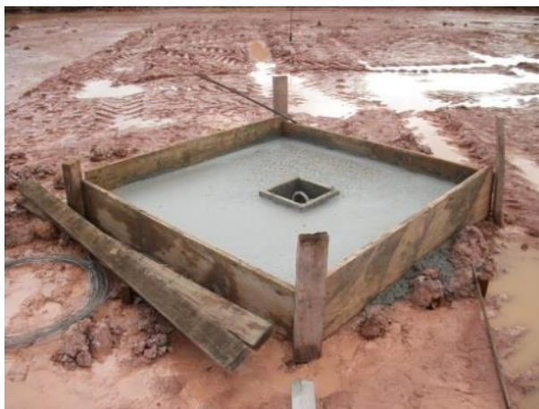
Fotografía 2-23 Muerto de anclaje
