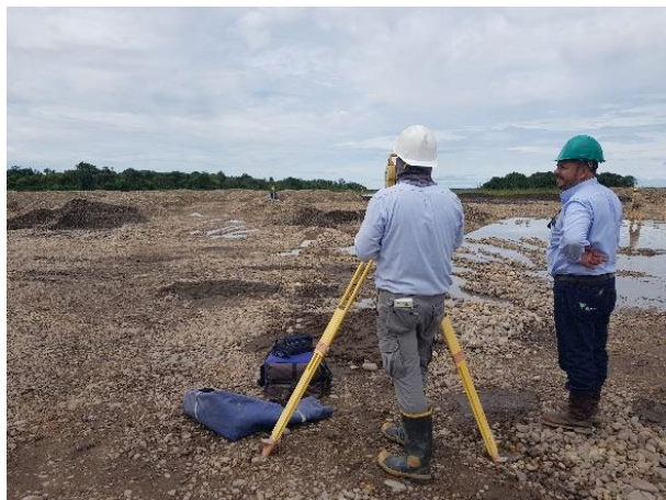
Fotografía 2-16 Localización y replanteo del área
