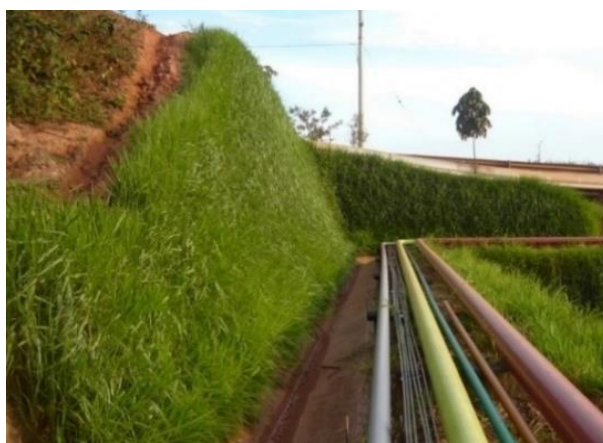
Fotografía 2-25 Revegetalización de taludes
