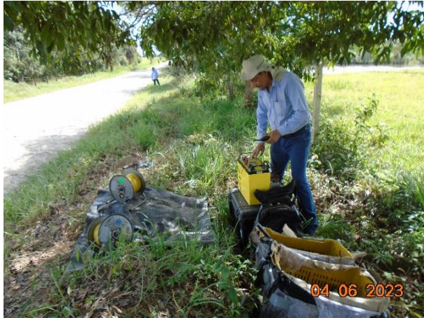
Fotografía 3.2.7-9 Ejecución de SEV-22
