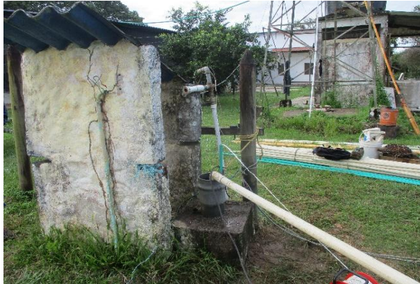
Fotografía 3.2.7-13 Medición de niveles dinámicos PB-02 (Pozo CPO5-005-P-El Boral), vereda San Isidro, municipio de Cabuyaro
