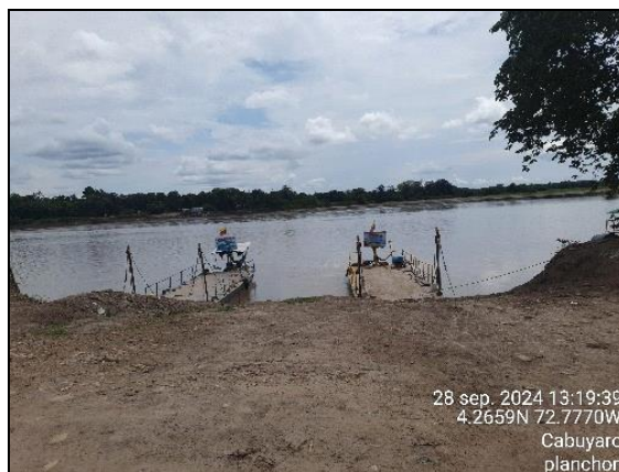
Fotografía 3.4.3-12 Cruce río Meta, sector Banqueta, Cabuyaro
