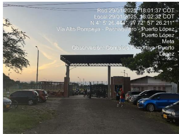
Fotografía 3.4.3-28 Polideportivo de Puerto López E 5047390,69709 N 2058181,77599 Fuente; Gessig 2025
