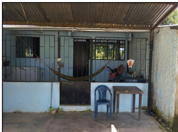
Fotografía 3.4.3-7 Vivienda en Cabuyaro con sus tipos de materiales
