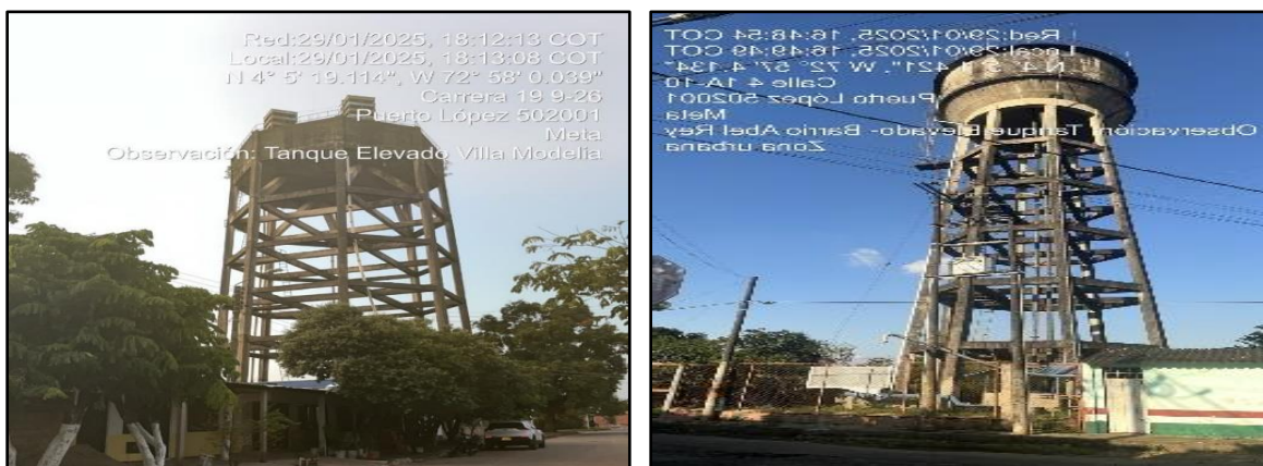
Fotografía 3.4.3-14 Infraestructura del acueducto casco urbano Puerto López
