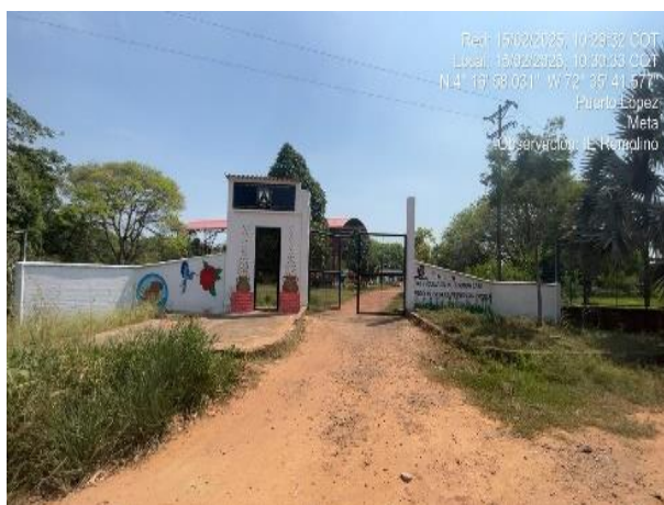
Fotografía 3.4.3-48 Infraestructura educativa de Remolino
