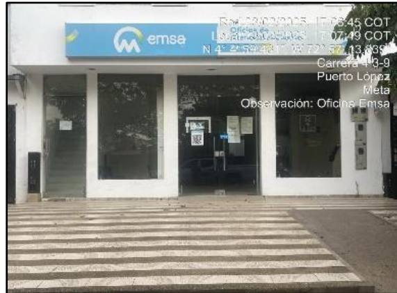
Fotografía 3.4.3-16 Oficinas de EMSA S.A en Puerto López
