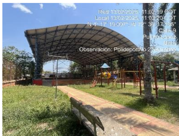
Fotografía 3.4.5-9 Polideportivo UTm Remolino
