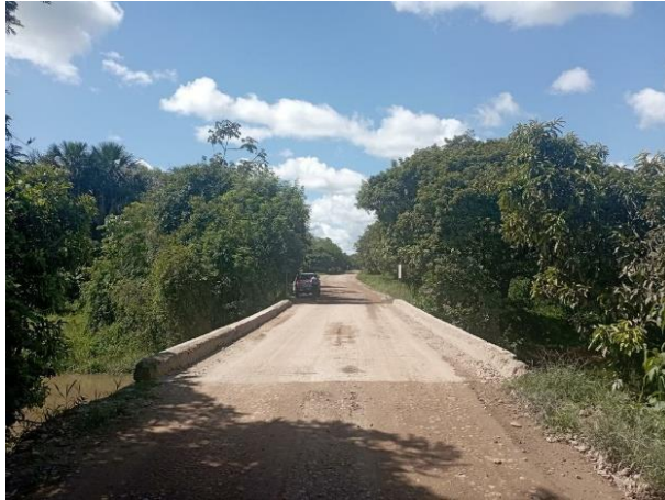
Fotografía 4.1-11 Acceso a la Franja de captación (CAP_06) sobre el caño Yarico.
