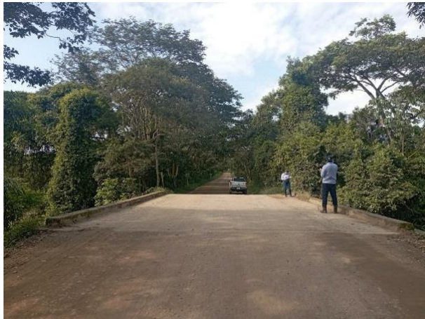
Fotografía 4.1-9 Acceso a la Franja de captación (CAP_05) sobre el caño Boral.
