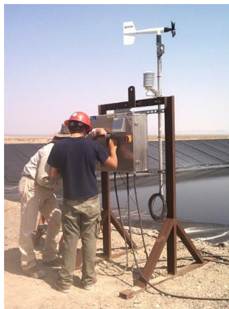
Figura 4.3-98 Estación meteorológica en un área de proceso de evaporación mecánica
