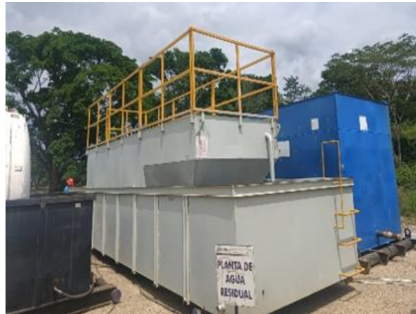
Fotografía 4.3-1 Planta de Tratamiento de Agua Residual PTAR
