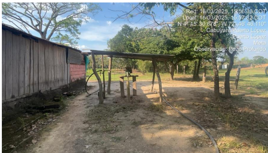
Fotografía 5.3-16 Captación de agua subterránea AP Bloque CPO-5 vereda Yurimena
