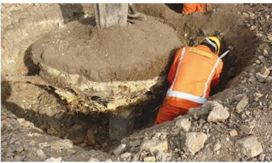
Labores de terminación del bloque
