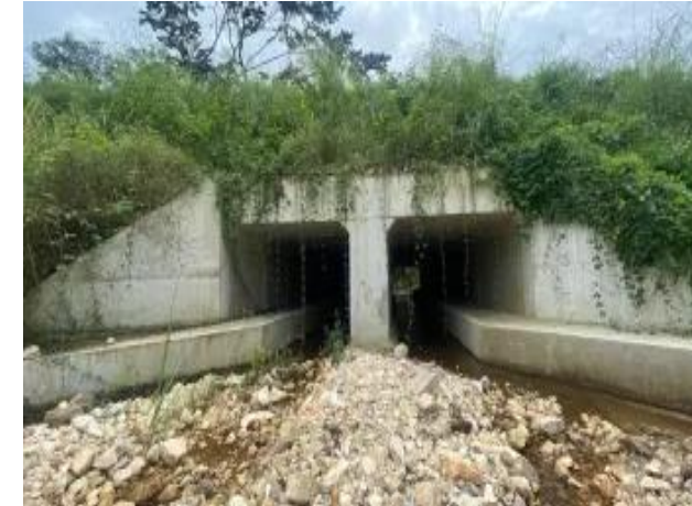
Figura 2: Obra de drenaje doble propósito
