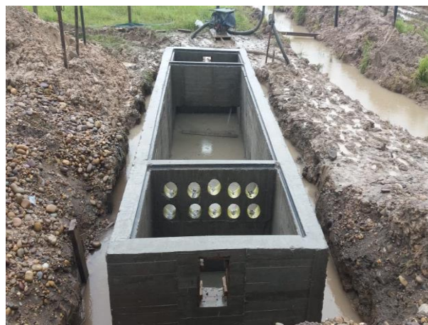
Fotografía 2-27 Construcción de desarenadores
