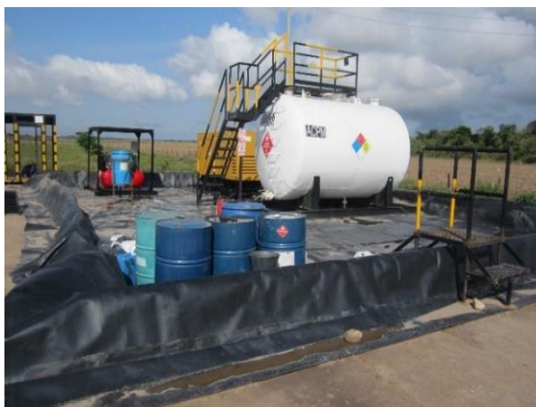
Fotografía 2-2 Área de almacenamiento de combustible
