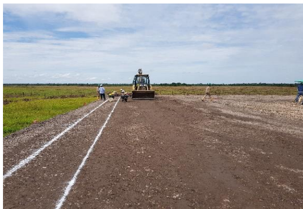
Fotografía 2-19 Construcción de cunetas perimetrales
