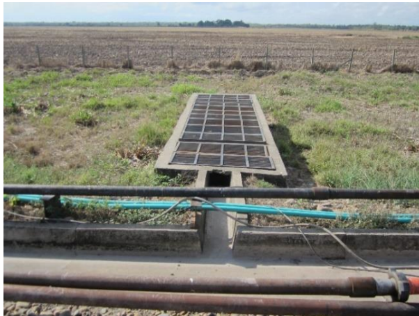
Fotografía 2-8 Desarenador
