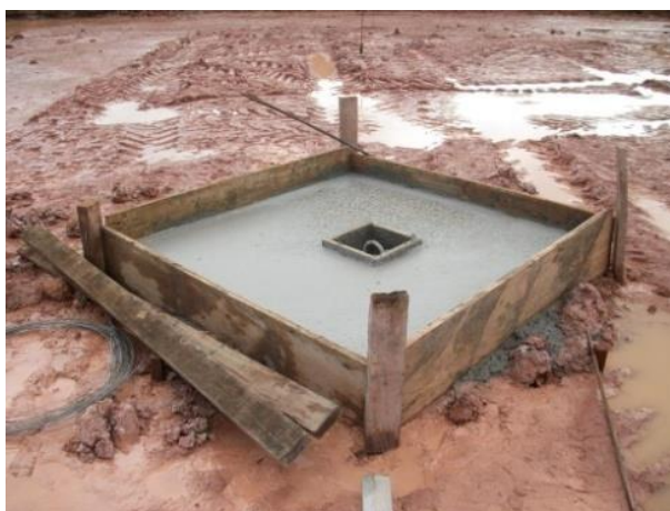
Fotografía 2-23 Muerto de anclaje
