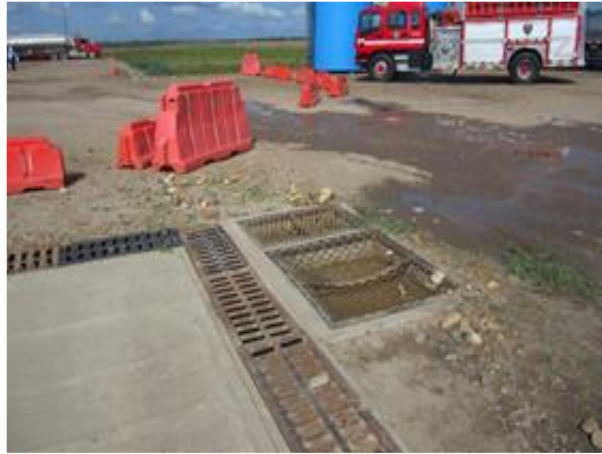
Fotografía 2-7 Desarenador
