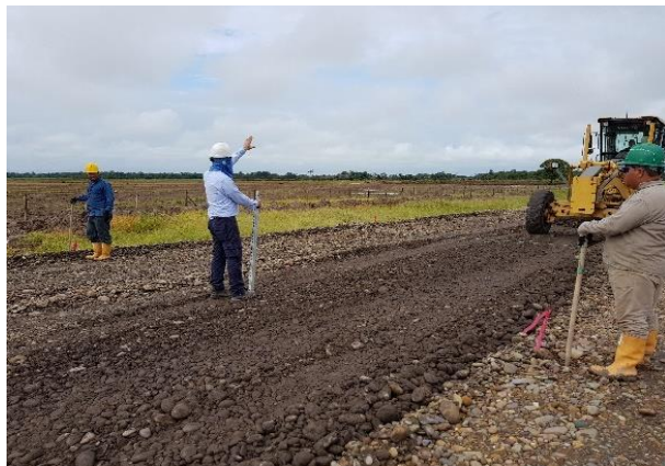
Fotografía 2-18 Cuneteo, escarificación, nivelación y compactación del terreno
