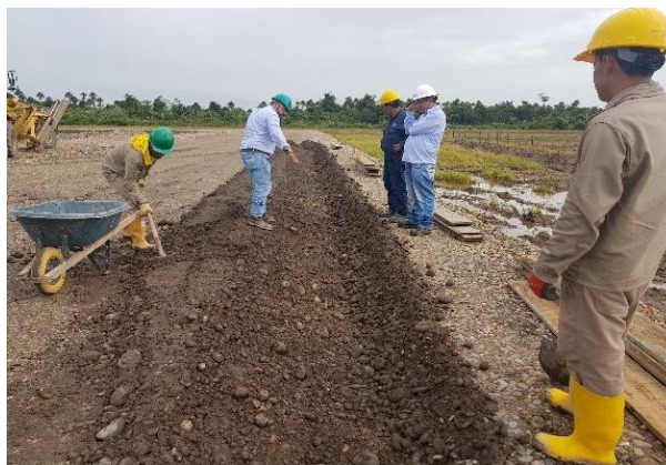
Fotografía 2-19 Construcción de cunetas perimetrales
