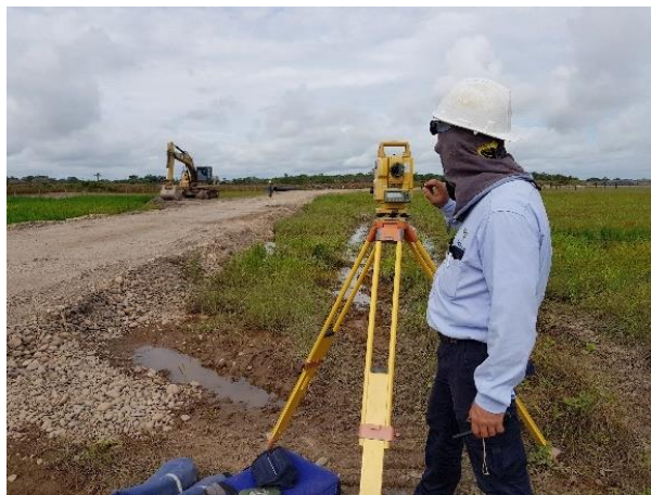
Fotografía 2-16 Localización y replanteo del área
